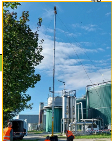
> Impianto di biogas in Emilia-Romagna
