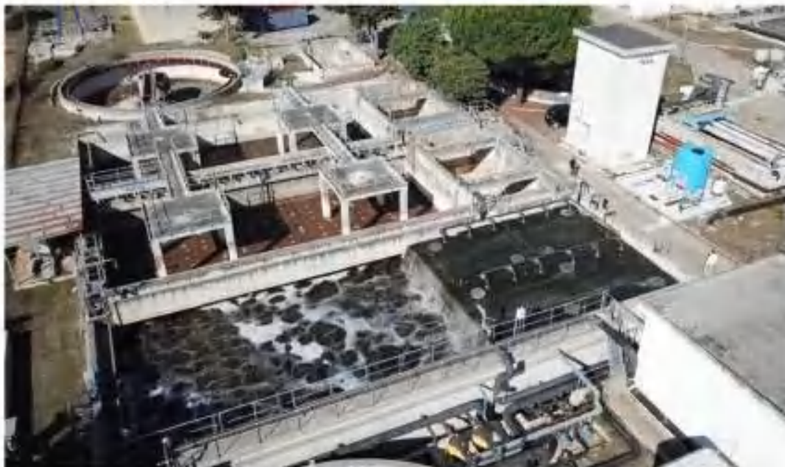
Impianto da 2000 abitanti equivalenti presso il depuratore di Putignano (BA)
